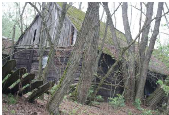
Рис. 3.3 Зруйнований приватний будинок у селі Лелів
