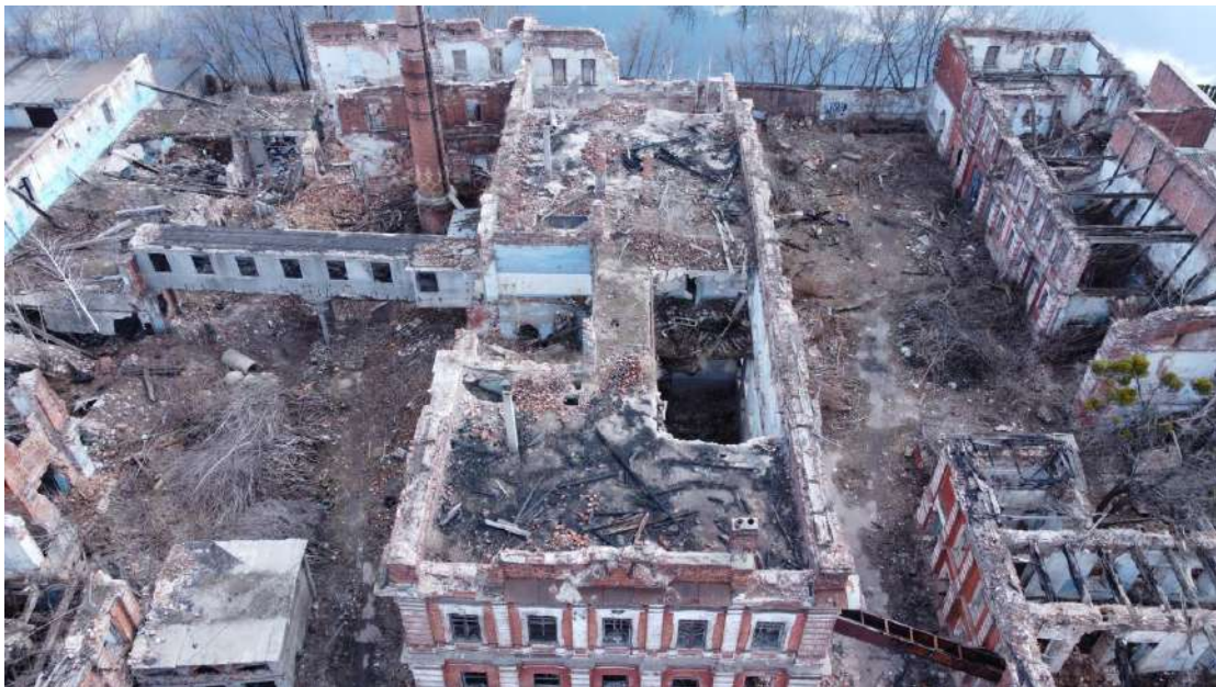
Рис. 3.2 Стан будівлі на лютий 2021 року
